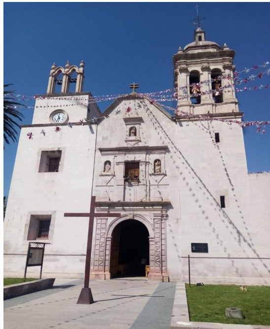
Figura 1. Muestra la portada principal del templo Jesús Nazareno, se aprecia un cambio de tonalidad en la parte inferior de los muros. Fotografía proporcionada por los autores, registro fotográfico realizado en 2024.
