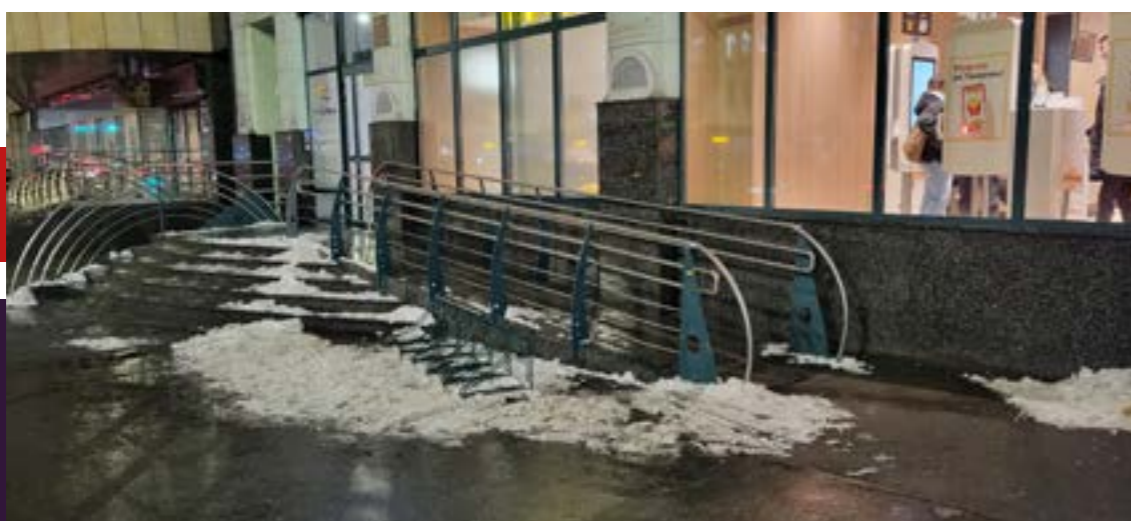
Díaz, M. 2023. Rampa para minusválidos en Wrocław. Polonia.[Fotografía]
