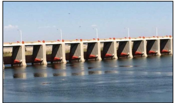
**Figura 4.** Presa Morelos, obra hidráulica de recepción de agua del río Colorado. Fotografía proporcionada por Carlos H. Castro González.
