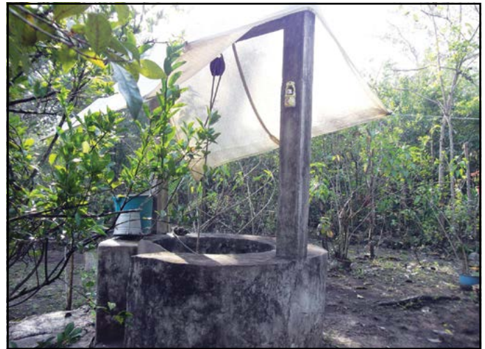
Figura 2. Pozo artesanal de Cuatlamayán, S. L. P. Fotografía propiedad de la autora.
