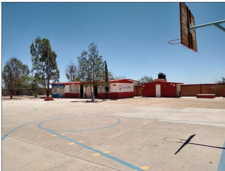
Figura 1. Exterior de una escuela primaria rural multigrado. Mexquitic de Carmona, San Luis Potosí. Fotografía del equipo de investigación.
