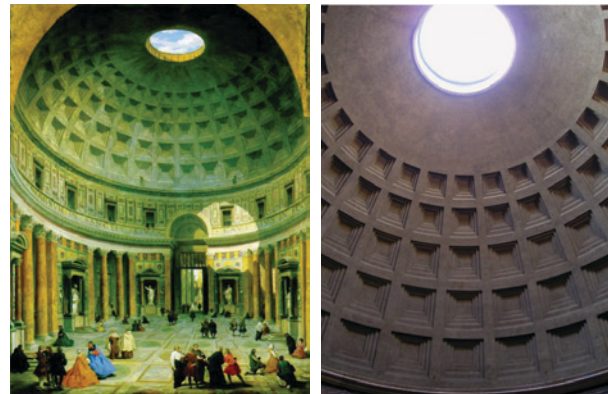
Figura 4. A la izquierda, interior del Panteón romano según grabado del S. XVIII de Panini. A la derecha, detalle actual del óculo y de los casetones.
