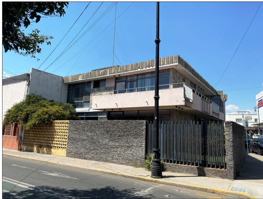
Figura 2. Inmueble racionalista en la esquina de Juan de Montoro e Hidalgo. Arq. Ramón Ortiz Bernadac. Se observa la utilización de materiales como la piedra de rajuela negra, piedra laja y celosía de concreto de la región de Aguascalientes, que constituyen una característica regional. Fotografía de 2022 del equipo de investigación.
