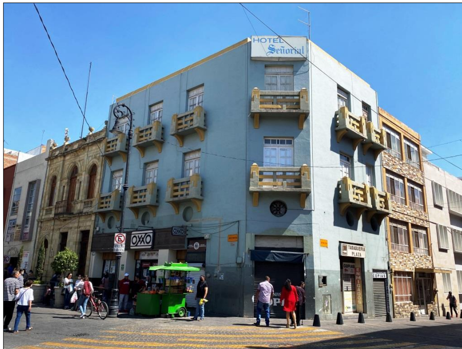
Figura 1. Finca Art Déco en la esquina de Juan de Montoro y Colón en el Centro Histórico de Aguascalientes. Constructor anónimo. Aplanado de cemento en muros y celosía prefabricada en balcones, propios de Aguascalientes. Fotografía de 2022 del equipo de investigación.
