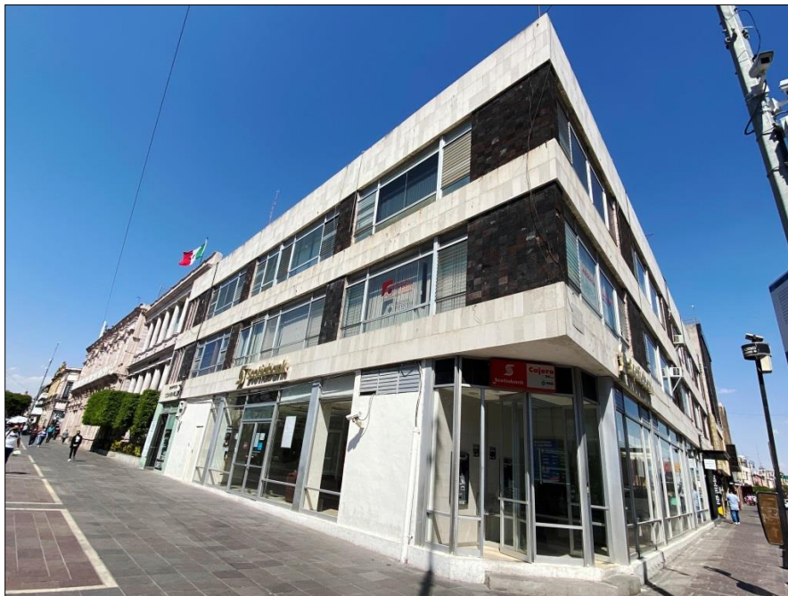
Figura 4. Edificio racionalista en la esquina de Juan de Montoro y Plaza Patria. Constructora San Marcos. Piedra gris en faldones y pretil, distintiva de Aguascalientes. Fotografía de 2022 del equipo de investigación.
