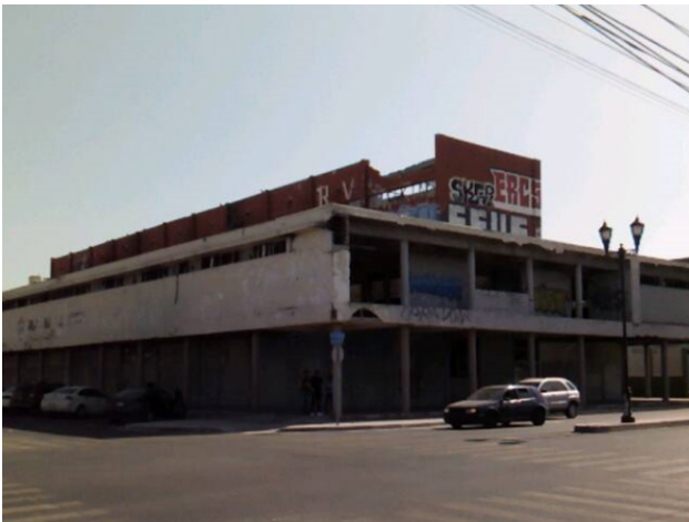
Figura 2. Vista del estado actual del Antiguo Mercado Municipal de Mexicali desde intersección de Avenida Álvaro Obregón y Calle Pedro F. Pérez y Ramírez. Fuente: Fotografía propia tomada el 5 de mayo de 2022 a las 16:03hrs.
